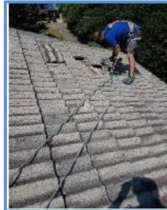
Con la tecnica **UOMO IN FUNE** e' possibile effettuare tale attivita' anche sulle coperture sprovviste di sistema di sicurezza anti-caduta a norma Uni/En 795.
